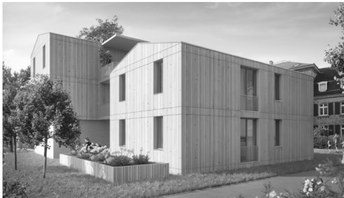
Abb.: Visualisierungen zeigen, wie die Wohnmodule an der an der Schottenstraße aussehen könnten
