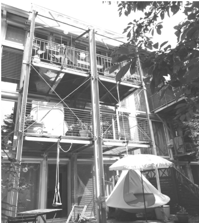
Abb.: Bestandsbauten Jungerhalde Zur Sonne ausgerichtete Fassade
