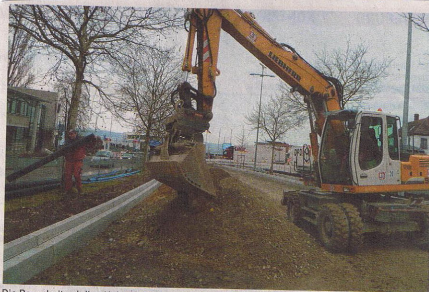
Die Bauarbeiter Julian Huber (links) und Ferdinand Weingärtner (im Bagger) sind fleißig dabei, die Lastwagenspuren zu sanieren. Bis Ende April soll alles fertig sein. BILD: BUNING
