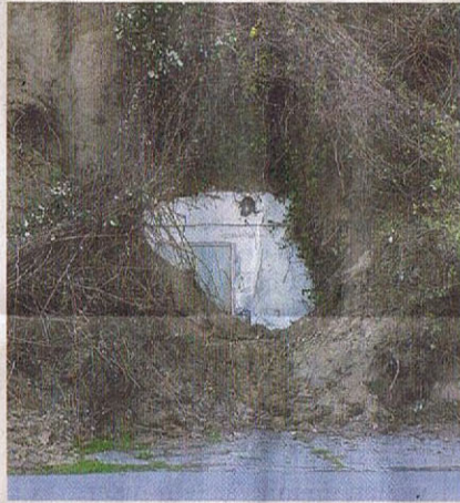
Dieser Zugang ist von den Erdmassen verschüttet worden.
