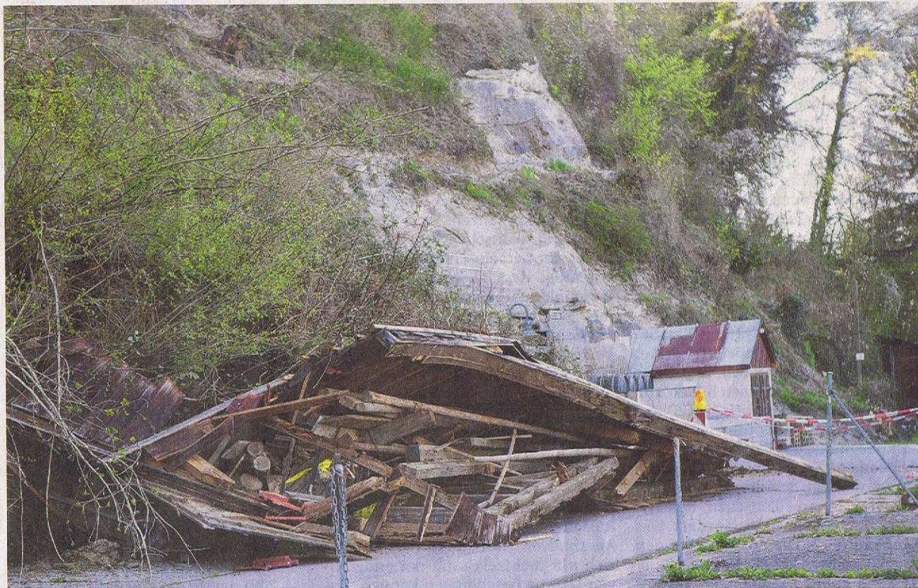
Vollkommen zerstört: Vom Schälkle-Schopf der Ruppener-Brauerei sind nach dem Erdrutsch am Hohenegg nur noch Trümmer übrig. Das Gebiet ist bis auf Weiteres gesperrt. BILDER: HANSER
